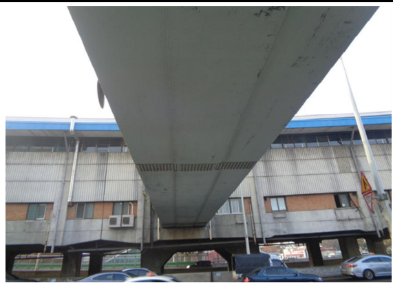
구로디지털단지역 4,5번 출입구 하부 상태양호
