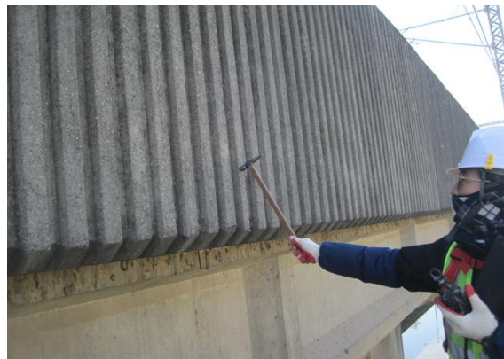
콘크리트 방음벽 외측 전경
