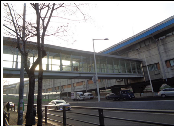
구로디지털단지역 4,5번 출입구 외부 상태양호
