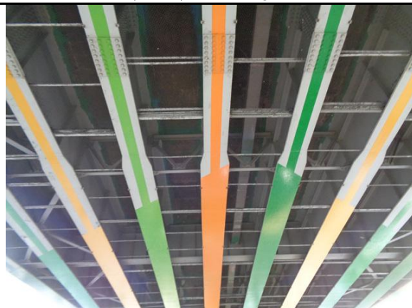
가로보 및 브레이싱 전경(S44)
