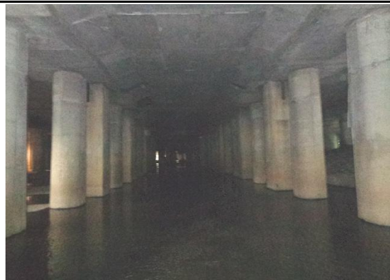
구로디지털단지역 하부 교각 전경
