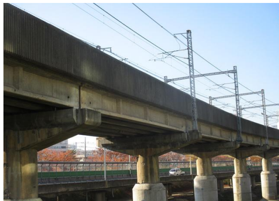
PSC 거더 전경
