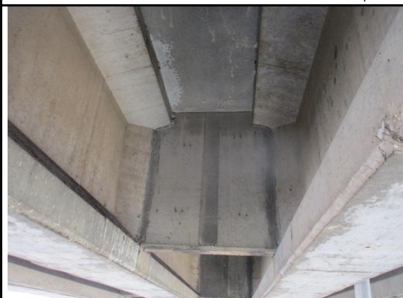
콘크리트 가로보 전경(S1~S41)
