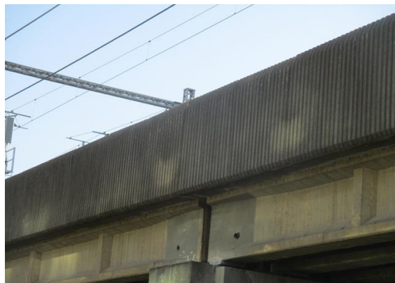
콘크리트 방음벽 내측 전경
