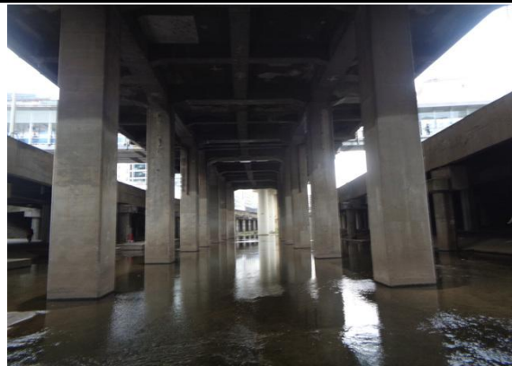
구로디지털단지역 하부 교각 전경
