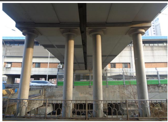
구로디지털단지역 2,3번 출입구 하부 상태양호
