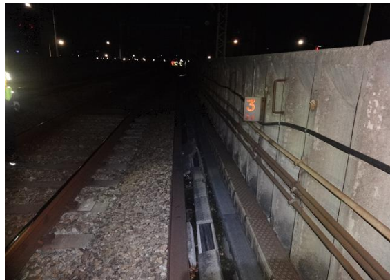
콘크리트 방음벽 내측 전경
