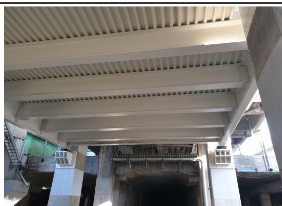
구로디지털단지 하부 정화조 설치 현황
