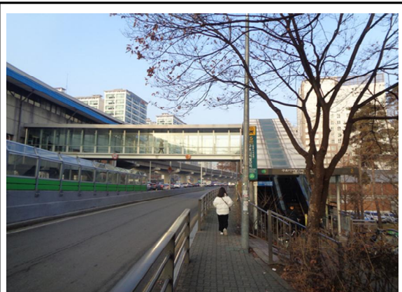
구로디지털단지역 4,5번 출입구 설치 현황
