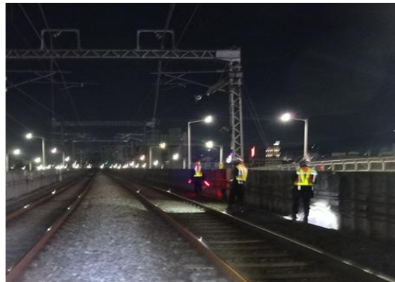
콘크리트 방음벽 외측 전경
