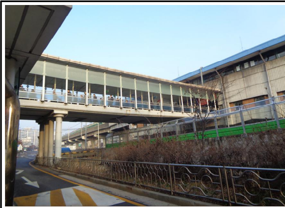
구로디지털단지역 2,3번 출입구 외부 상태양호
