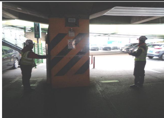
구로디지털단지역 하부 교각 전경
