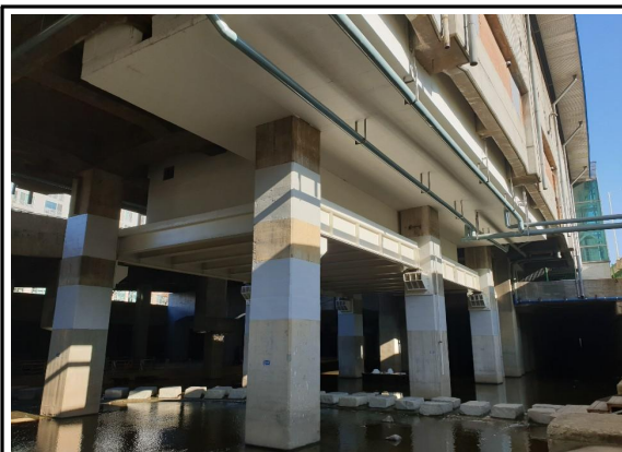
구로디지털단지 하부 정화조 설치 현황
