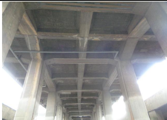
구로디지털단지역 하부 바닥판 전경
