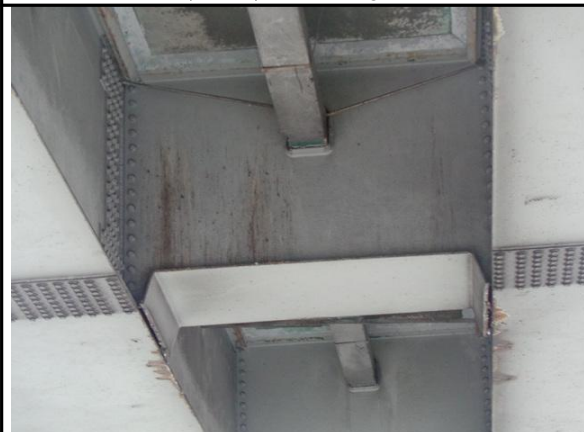
강재 가로보 전경(S42~S43)
