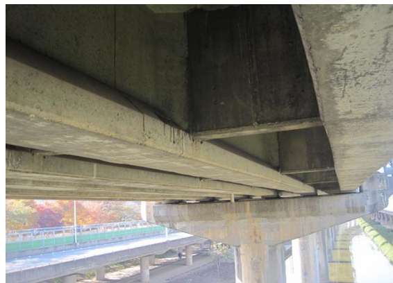
STB 거더 전경
