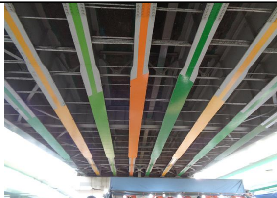
SPG 거더 전경
