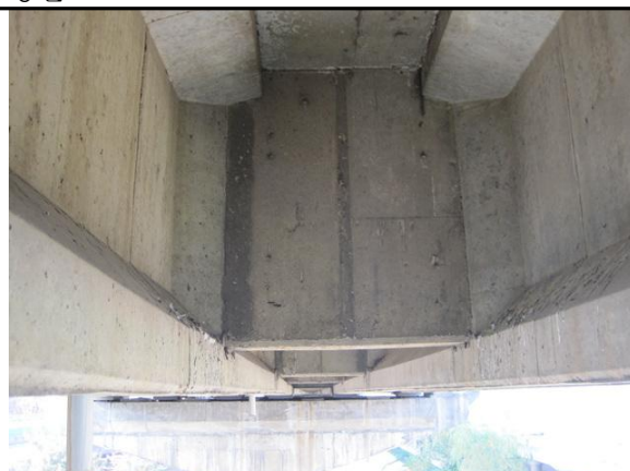
콘크리트 가로보 전경(S1~S41)
