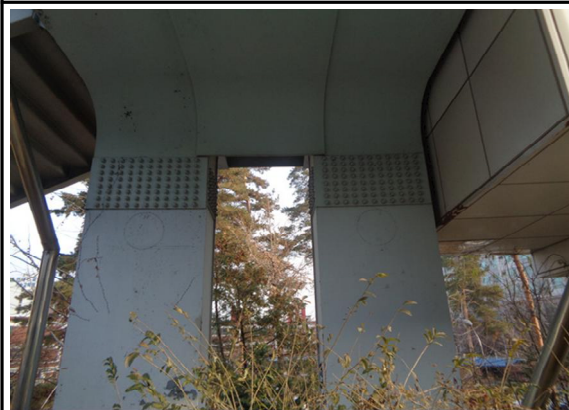
구로디지털단지역 4,5번 출입구 하부 상태양호
