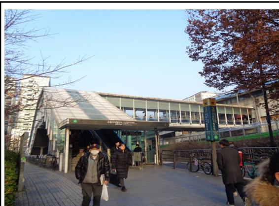
구로디지털단지역 2,3번 출입구 설치 현황
