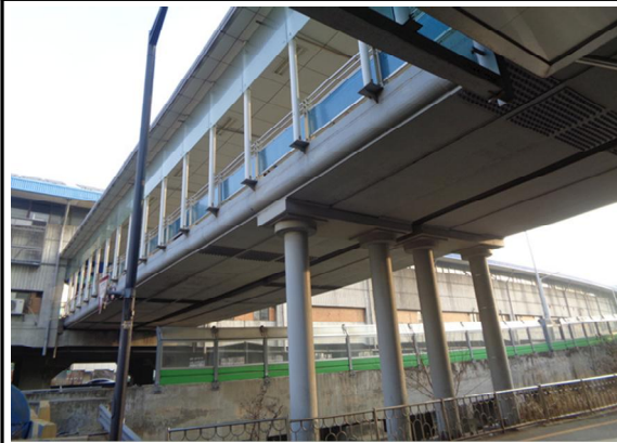
구로디지털단지역 2,3번 출입구 외부 상태양호
